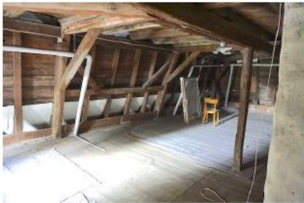
nicht ausgebautes Dachgeschoss im Pfarrhaus
