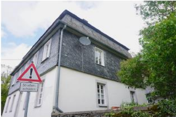
Ansicht von Süden auf das Pfarrhaus
