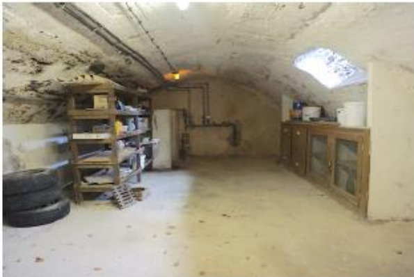
Bruchsteingewölbekeller unter dem Pfarrhaus
