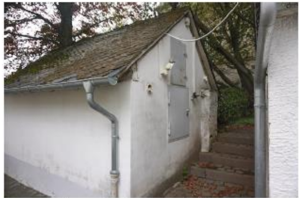
ehemaliges landwirtschaftliches Nebengebäude als Tankraum zum Pfarrhaus
