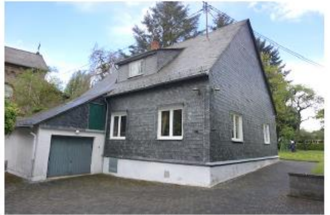
Hofansicht des Gemeindehauses
