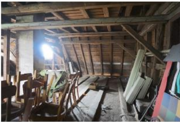
Blick in das Dachgeschoss des Gemeindehauses
